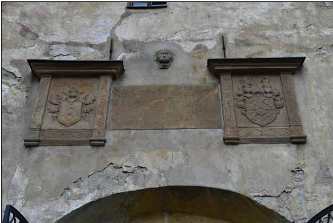
Erby na juhovýchodnej fasáde objektu.
