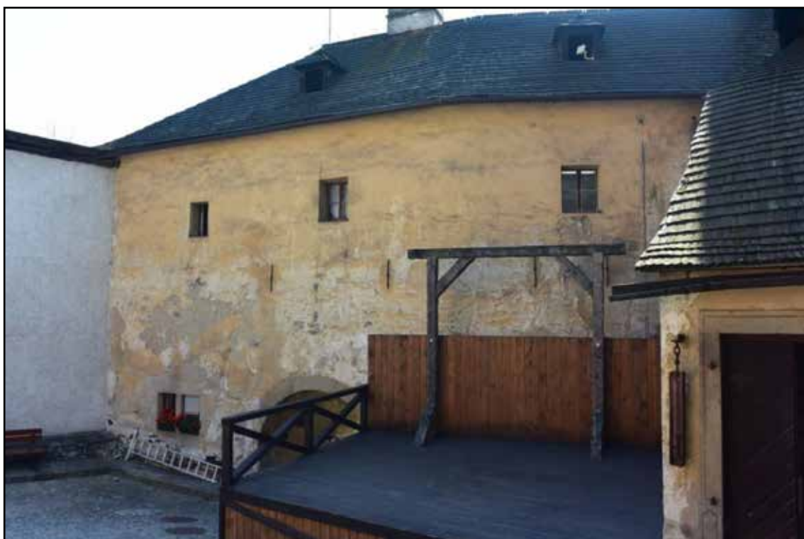
Severná fasáda objektu
