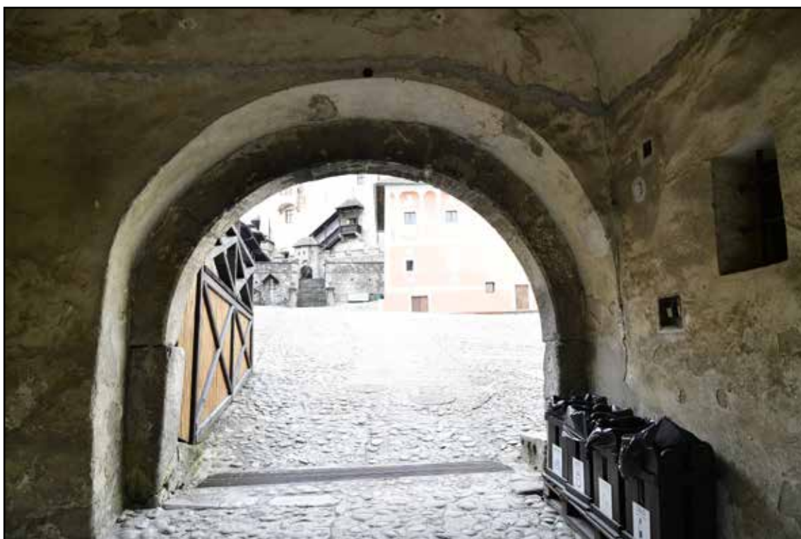
Portál do podjazdu na severnej fasáde
