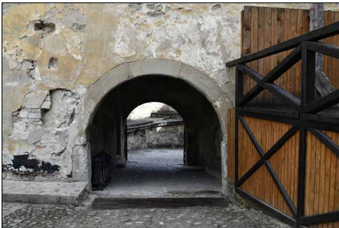
Portál do podjazdu na severnej fasáde
