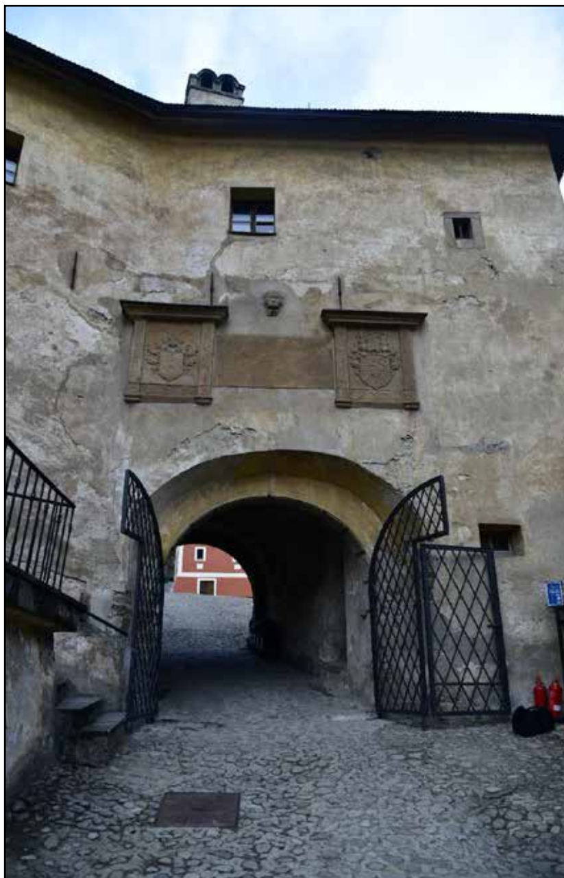
Južná fasáda - portál do podjazdu a výzdoba
