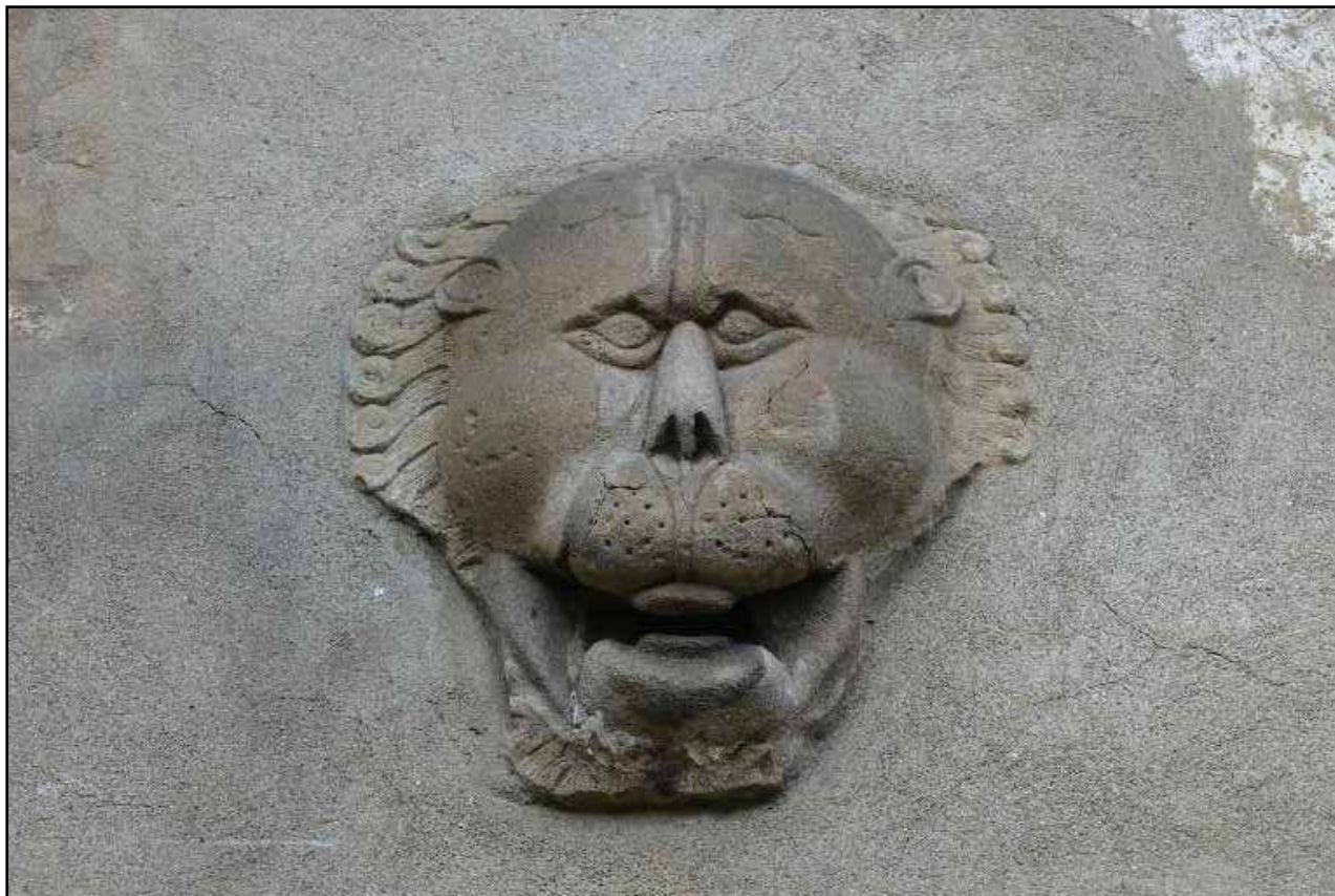
Reliéf leva nad erbami na juhovýchodnej fasáde objektu.
