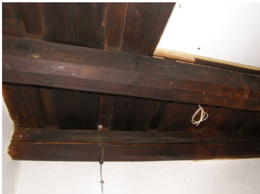
27. Detail stropu 2.NP
