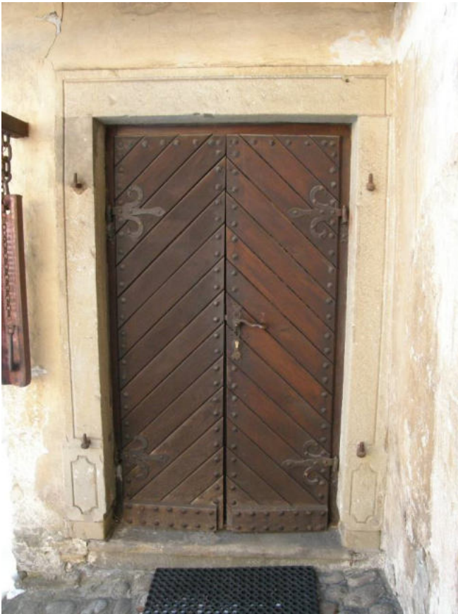
28. Vstupný portál do schodiska
