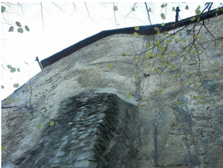
23. Celkový pohľad východnú fasádu
