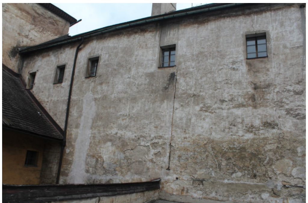
11. Pohľad na časť západnej fasády budovy
