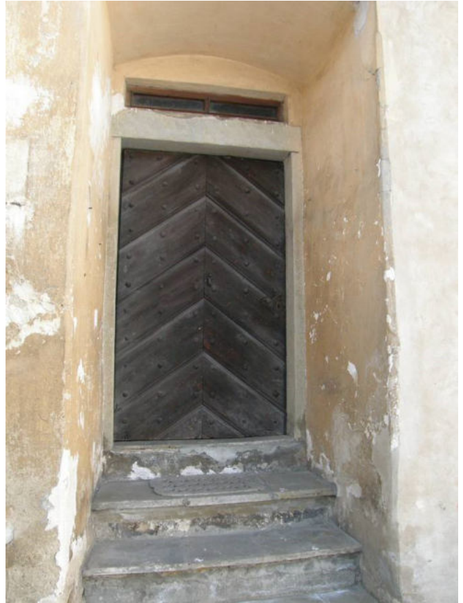
29. Vstupný portál do západného krídla
