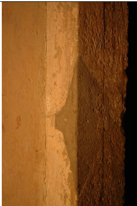
cementové tmely, miesto chýbajúceho pántu
