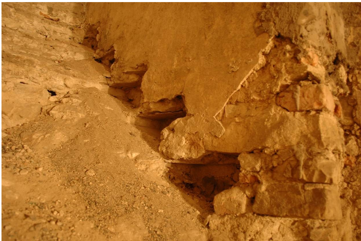
3. Miestnosť A, časť bývalého schodiska.
