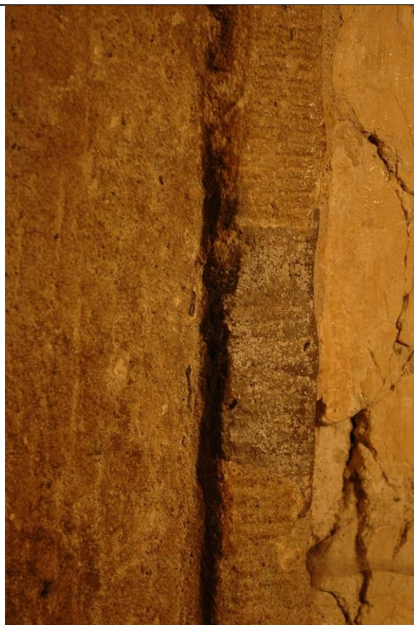
Miestnosť C: kamenný portál, redukovaná skladba kamenných blokov.
