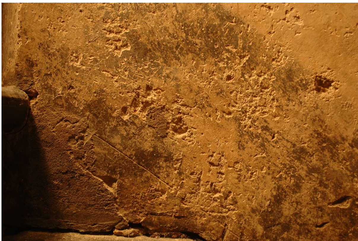
15. Miestnosť B, juhovýchodná strana, detail predrytej linky schodiska.
