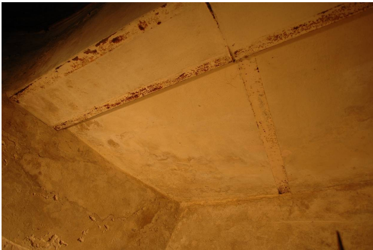
23. Miestnosť C, severozápadná strana, sekundárne preklenutý priestor nad oknom, pomocou kovovej konštrukcie.
