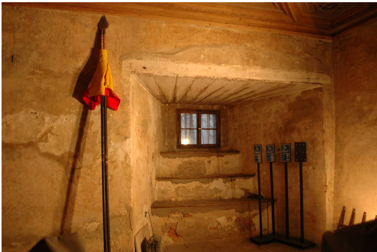
10. Miestnosť B, juhozápadná strana, okenný otvor so stupňovitým parapetom.
