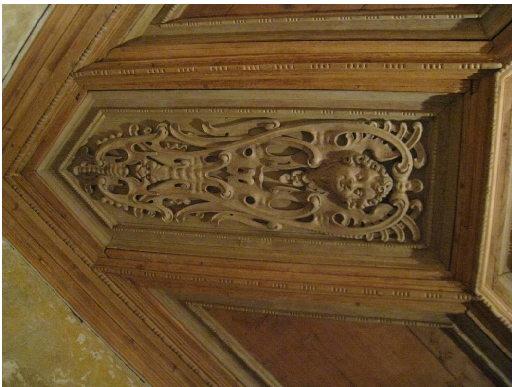
18. Miestnosť B, časť dreveného stropu, stav po reštaurovaní.
