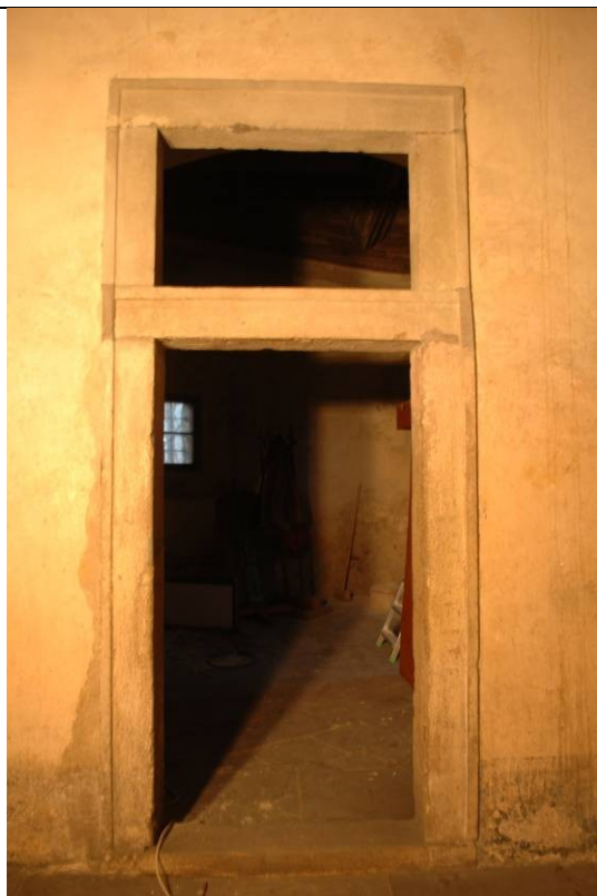
úpravy na obvodovej páske
