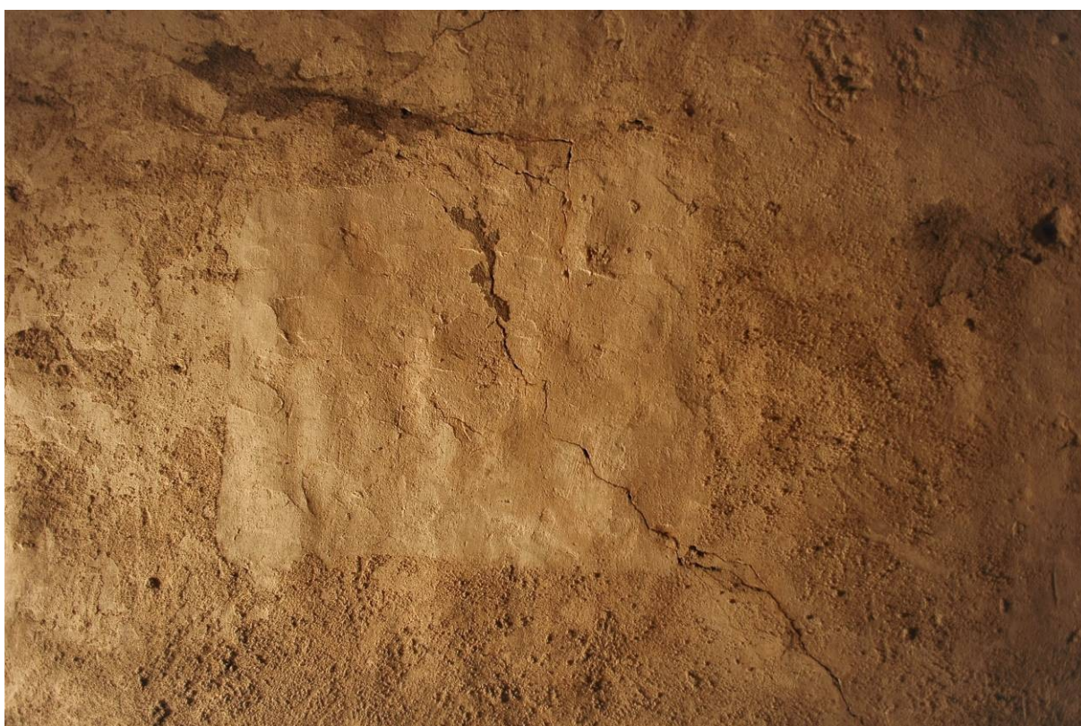
9. Miestnosť A, charakter spracovania povrchu omietkovej vrstvy. (časť exteriérovej fasády stredný hrad)
