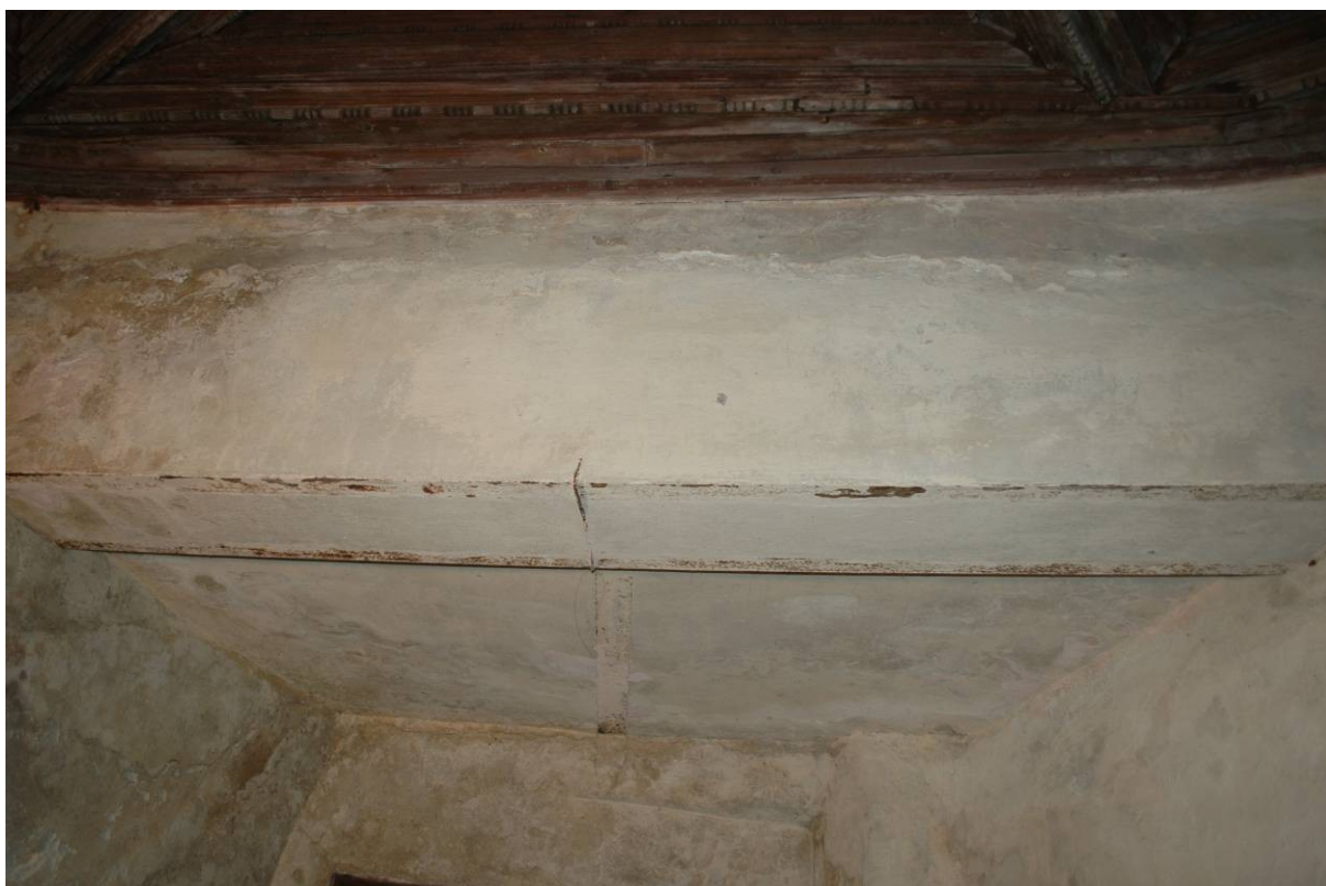
24. Miestnosť C, severozápadná strana, sekundárne preklenutý priestor nad oknom, pomocou kovovej konštrukcie.
