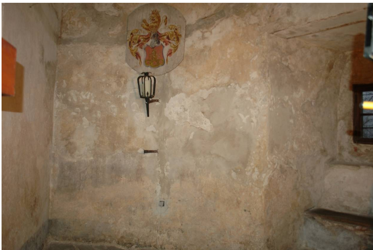
21. Miestnosť C, západná strana, vedenie elektrických rozvodov a početné lokálne tmely.
