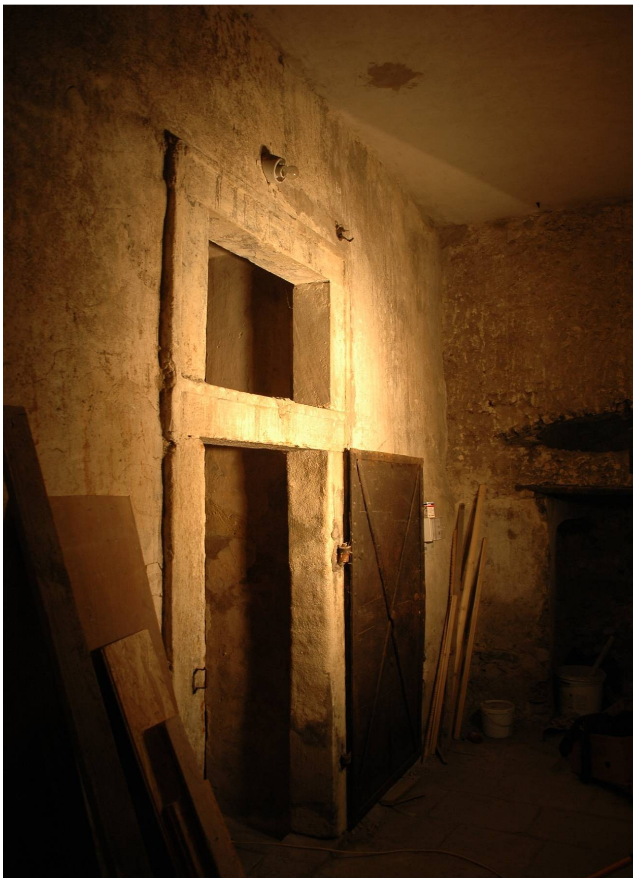
1. Miestnosť A, severozápadná strana.
