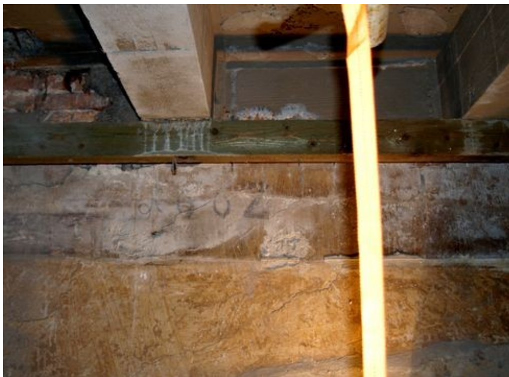
19. Miestnosť B, stav po rozsiahlej stabilizácii stropu a podláh 2.NP západnej bašty.
