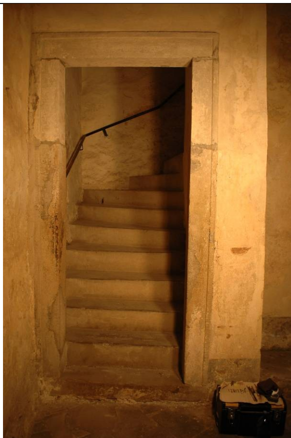
Miestnosť C: kamenný portál, redukovaná skladba kamenných blokov.
